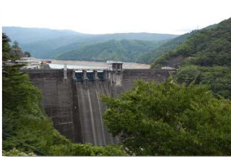
井川ダム外観
